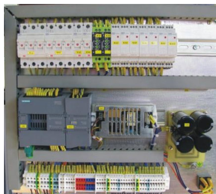
Provedení vestavné na dveře rozváděče
