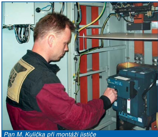
Pan M. Kulička při montáži jističe
